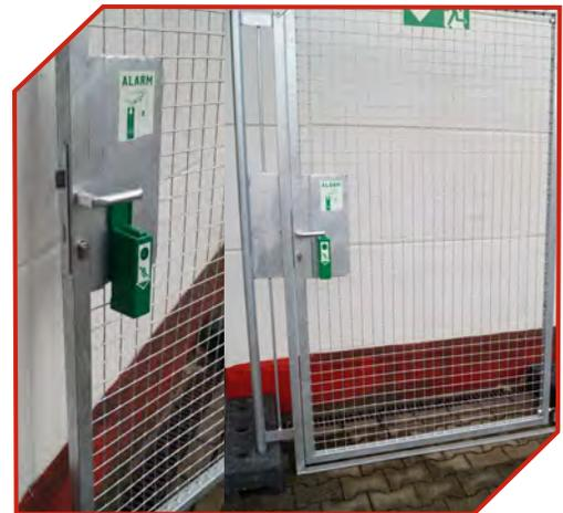
In Verschlussstellung sichert der EH-Türwächter den Türdrücker, die Tür kann im Notfall mit einem Handgriff begangen werden. Durch das herunterdrücken der Türklinke verschiebt sich der Türwächter senkrecht nach unten und gibt der Klinke den Weg frei. Gleichzeitig ertönt ein Dauersignal.
