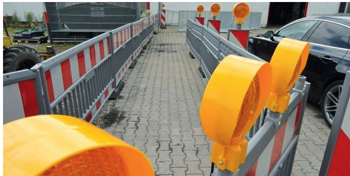
Sauber und vor allem sicher trennt die Gehwegabsperung Baustelle und Fußgängerbereich. Foto: HMR
