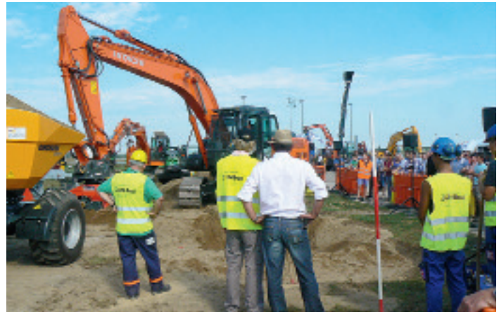
Die Leute sind da, wo die action ist: Gut besuchte Musterbaustelle auf der Tiefbau live. Foto: st/Müller
