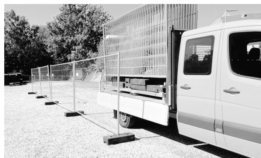
Ungehindertes Zugang zu den Füßen, wenn ein Zaunelement entnommen worden ist. Foto: HMR
