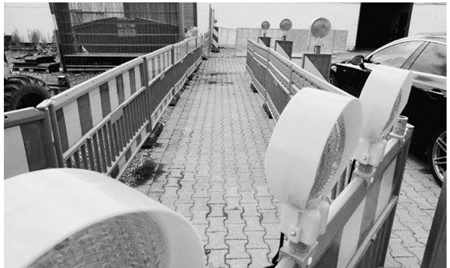
Die Abgrenzung zwischen Straßenverkehr und Fußgänger muss sichergestellt sein und die Absperrungen müssen komplett verbunden sein. Foto: HMR
