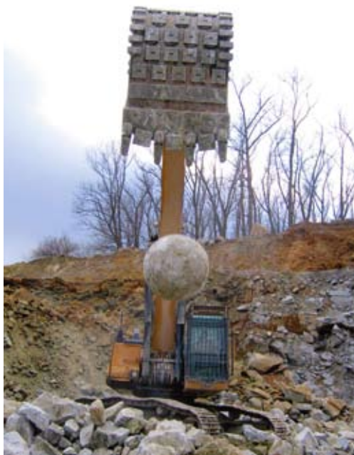
Der Felstieflöffel von HS-Schoch hebt die 4,5 t schwere Eisenkugel auf Abwurfhöhe.
